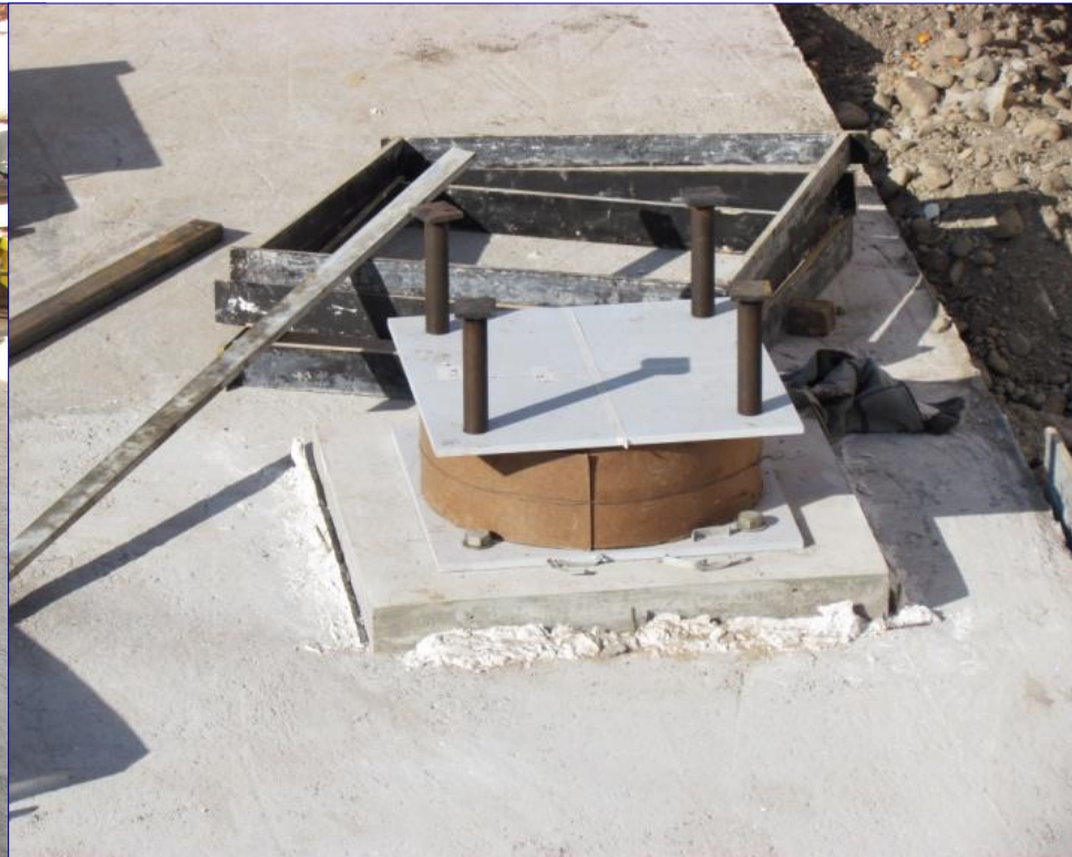
Instalación de aisladores
