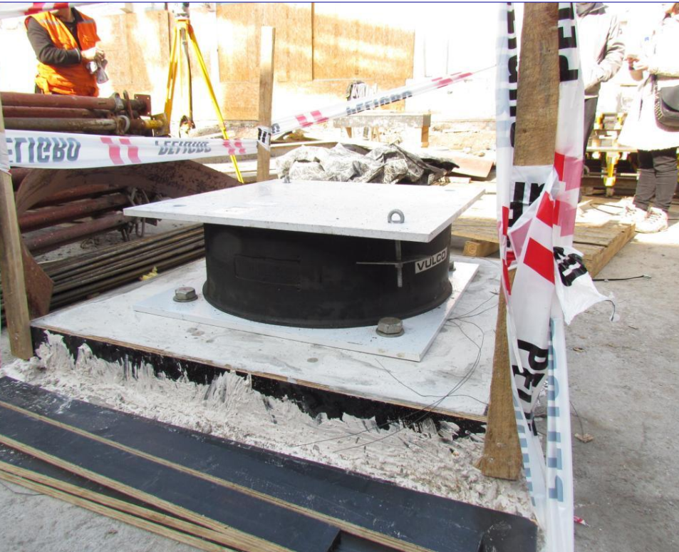
Instalación de aisladores
